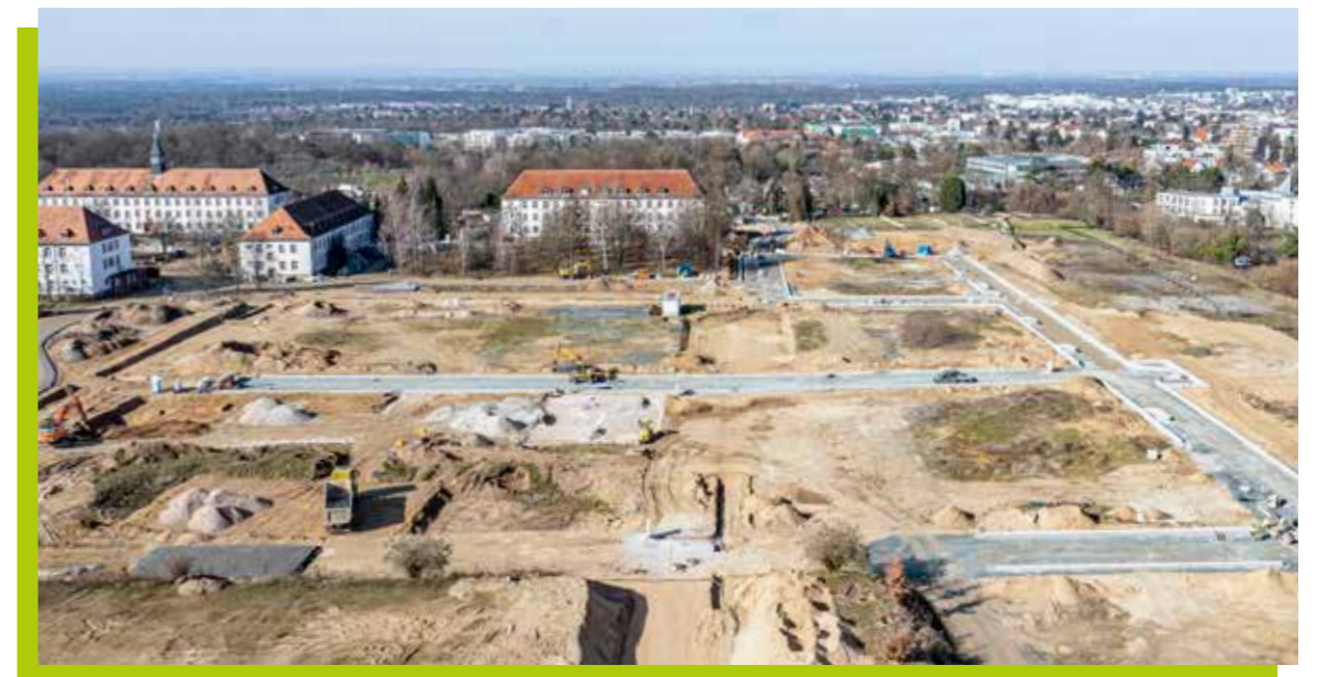
Die Infrastrukturarbeiten im neuen Quartier sind 2022 gestartet
