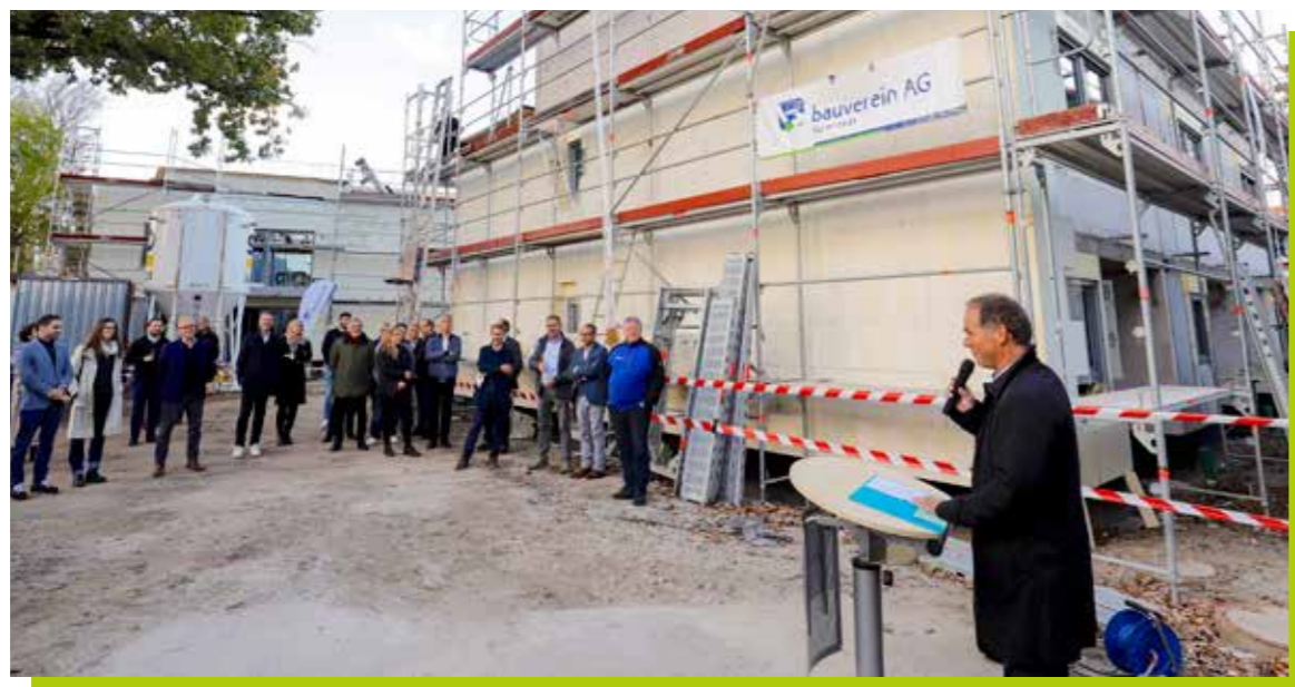
Halbzeit für das Neubauprojekt mit 30 Wohnungen in der Frankfurter Landstraße: Auf dem ehemaligen Gelände der Feuerwehr wurde der Richtkranz gehisst
