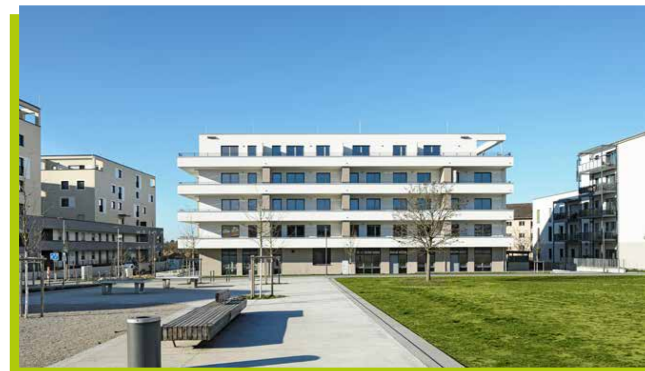
Der Neubau in der Lincoln-Siedlung auf dem Baufeld N4 wurde im Frühjahr 2023 fertiggestellt
