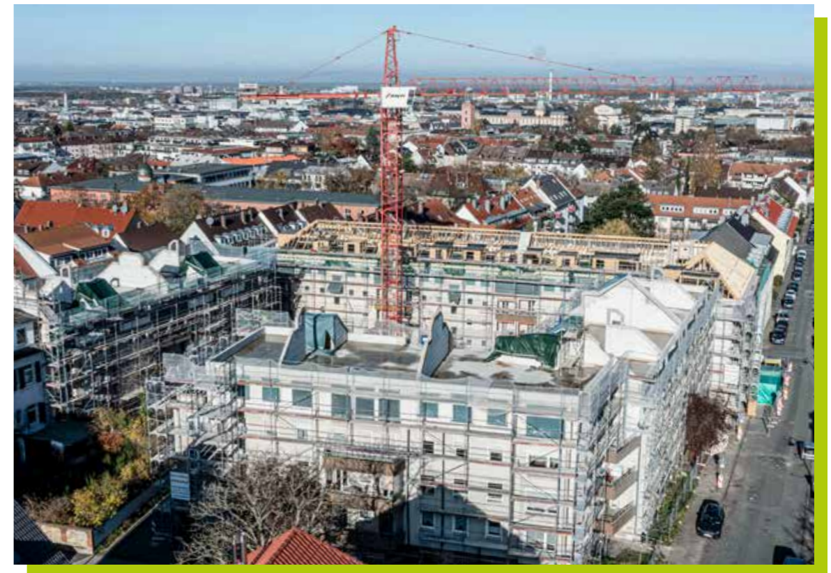
Der Mathildenhof im Bau: Durch Aufstockung wurde weiterer Wohnraum geschaffen. Die neu installierten PV-Anlagen liefern klimafreundlichen Strom
